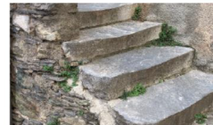
Perron maçonné en granite
