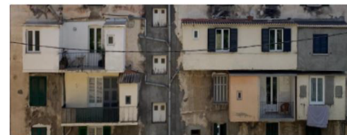
Façade enduite avec béton
