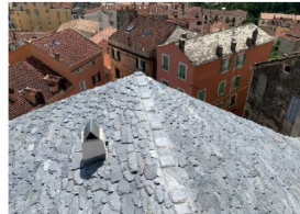
Photographie illustrant la rénovation de la toiture en lauze de la maison Gaffori.
